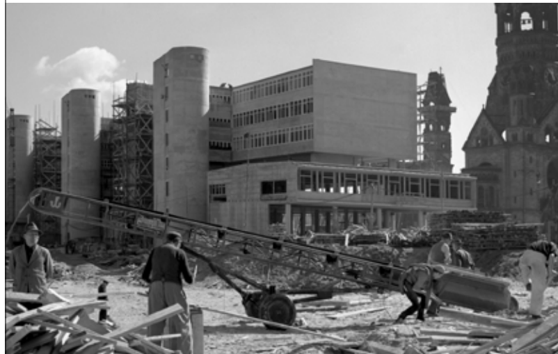
2. Die Baustelle 1956: Blick auf die Rückseite des Langbaus (zukünftiges Bikinihaus).
